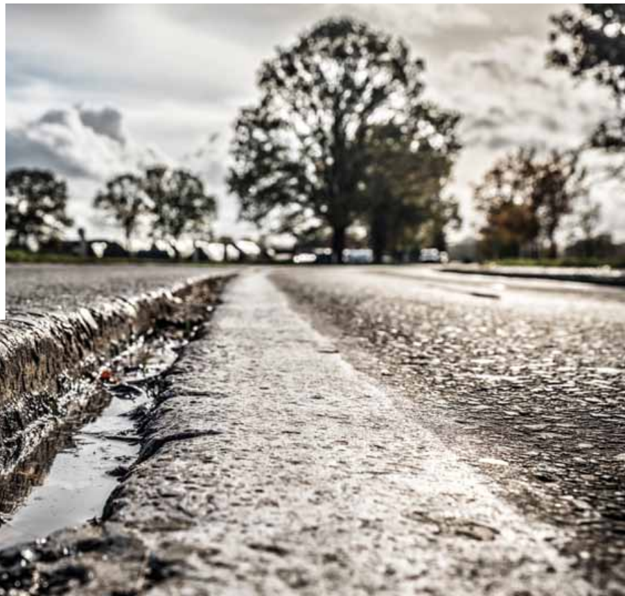
▼ U ziet hier geen stoeprand, maar een heel diepe scheur in het midden van de N174 in Schaffen bij Diest. Het Belgisch leger van de nabijgelegen militaire basis rijdt hier zeker 90 km/uur.
