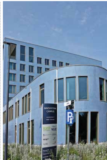
▶ Het nieuwe gebouw van het ILVO en het VLIZ in Oostende. Foto © Winny Matheussen
